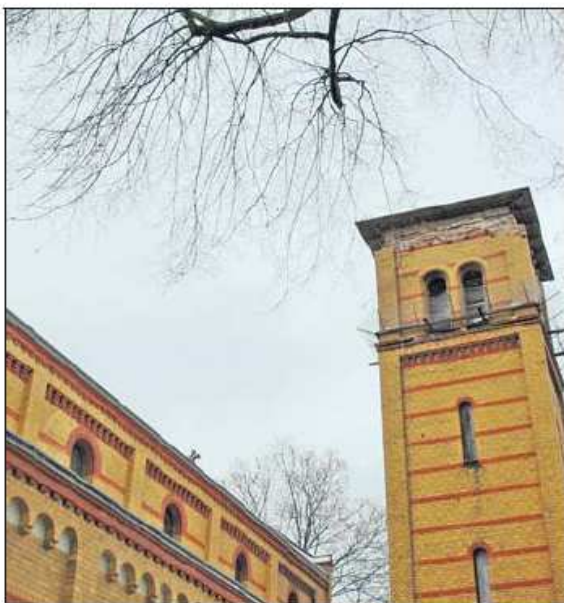
Der Wuhlgarten e.V. will als neuer Besitzer der früheren Vivantes-Kirche unter anderem den Turm sanieren lassen. Foto: hari
